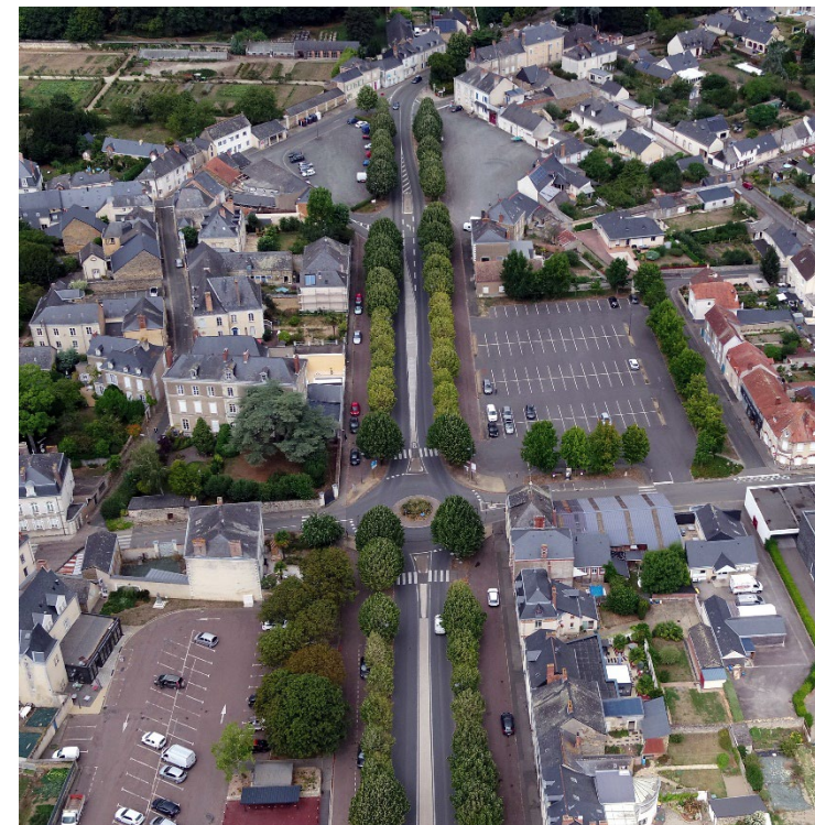
Photographie prise par drone 2022 © Ville de Craon
