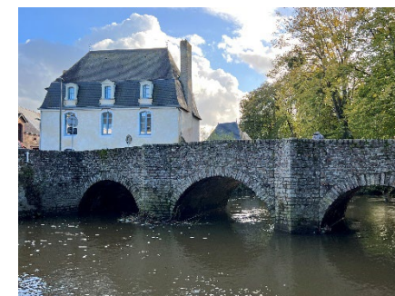
Rue du Vieux Pont © BE-AUA
