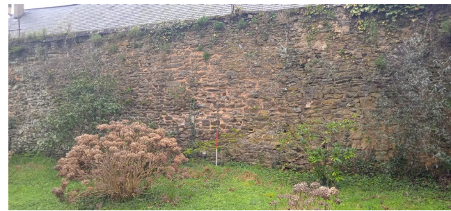
8 – rempart potager du château
