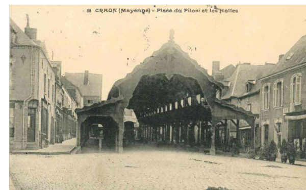
Carte postale ancienne, Place du Pilon et les Halles, Source : AD53
