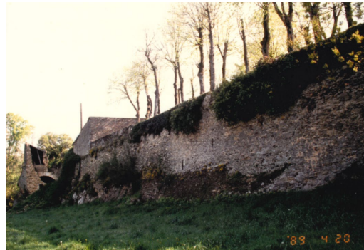
10 – rempart en continuité du corps de garde ( ?)
